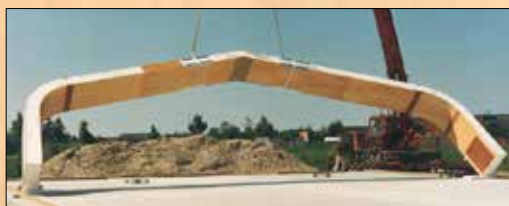
Newood, bâtiment industriel, longueur 30 m, portée libre 15 m, hauteur 6 m, épaisseur de la coque 0,40 m, avec auvent et portes coulissantes Newood.
