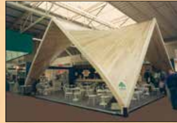
«Quadra», exposition d'éléments de toiture en paraboles hyperboliques à l'Exposition internationale du Jaarbeurs à Utrecht (Pays-Bas).
