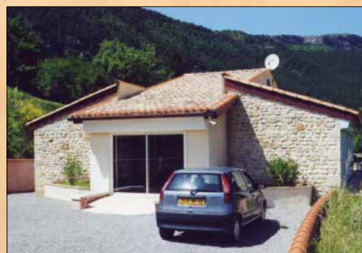
Villa Oykos, aire d'arrivée. Porte-fenêtre d'un bureau indépendant avec rampe d'accès pour handicapés. L'entrée principale se trouvant à gauche. Les pierres naturelles sont posées en parement de la forme constructive Newood.
