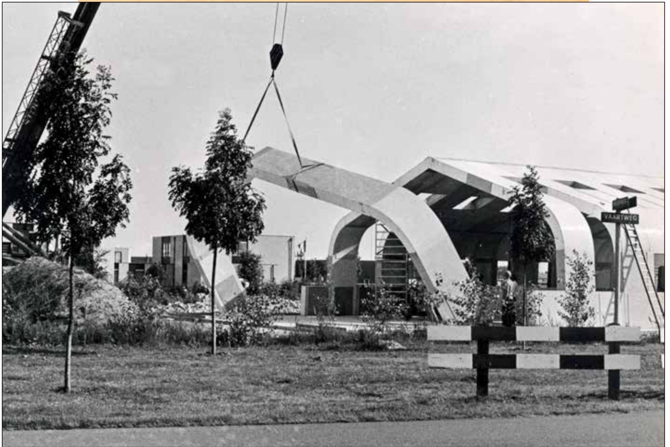
Newood, construção industrial, fim da montagem dos segmentos de casco.
