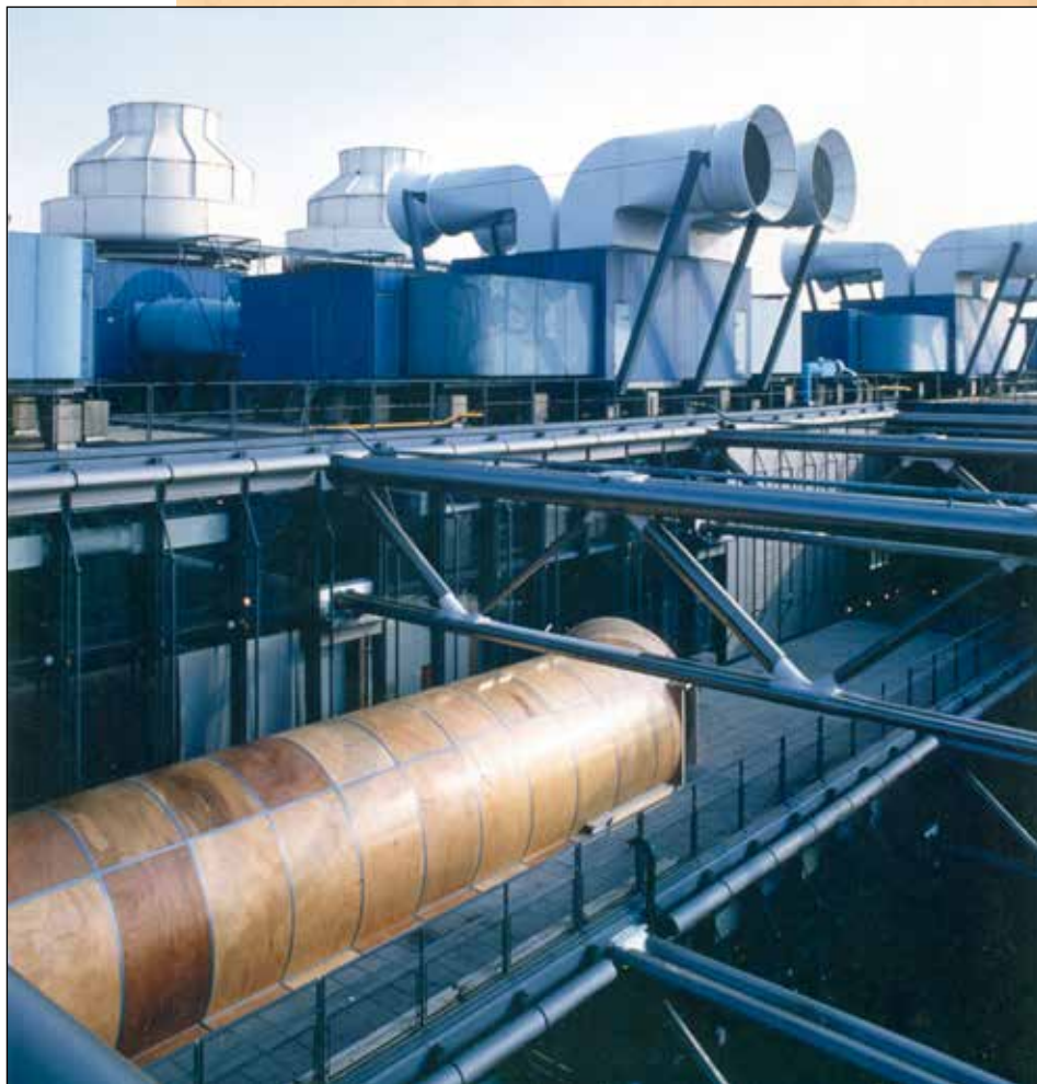
Coursive Newood na forma de ómega. De um comprimento de 26 m e um diâmetro de 4 m. Curvar à extremidade de 60 graus. Centro Georges Pompidou à Paris.
