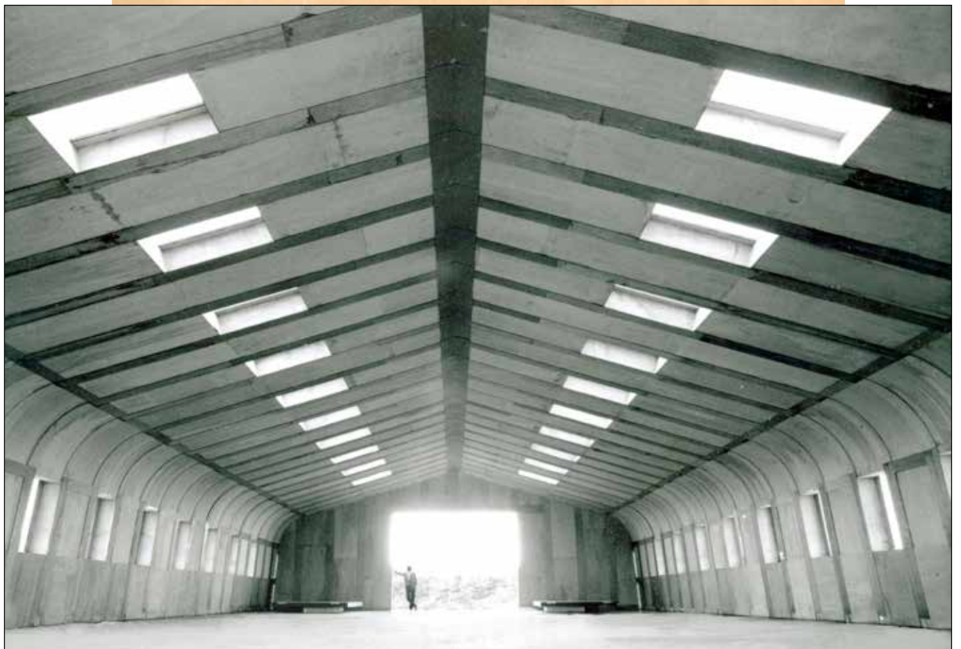
Newood, construção industrial, forma construtiva, vista do interior.
