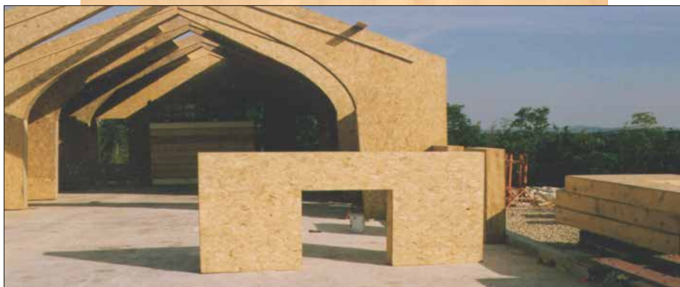
Newood/Jasse em cursos de montagem. Ao primeiro plano, de pé, um elemento muro/meiojanela elevados. Alcance livre de 10 m., Altura 4,50 m, Comprimento 20 m.
