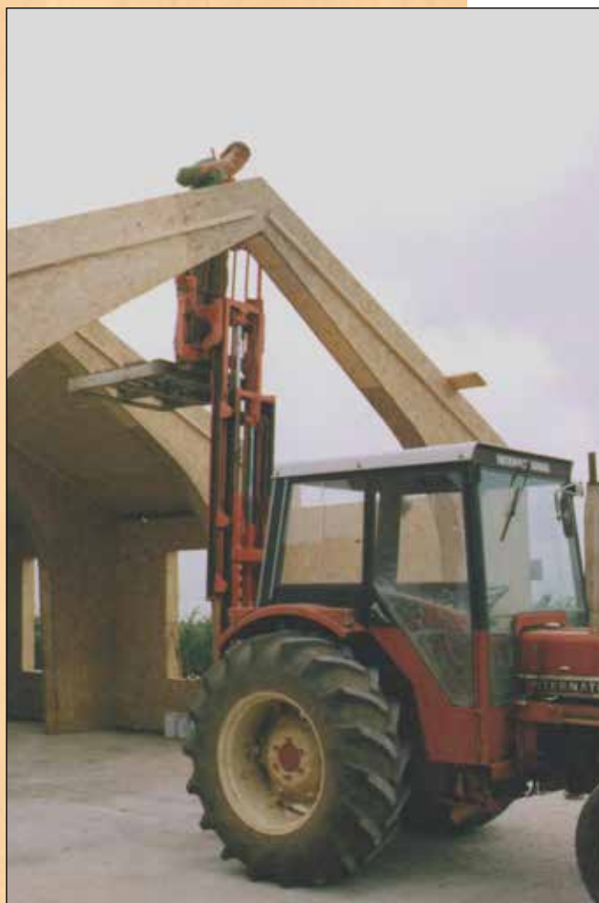
Newood/Jasse, constituição de uma arca pela montagem de duas meioarcas.
