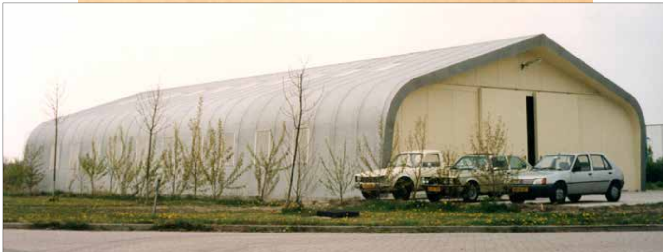
Newood, construção industrial, comprimento 30 m, alcance livre 15 m, altura 6 m, espessura do casco 0,40 m, com capa e portas de correr Newood.
