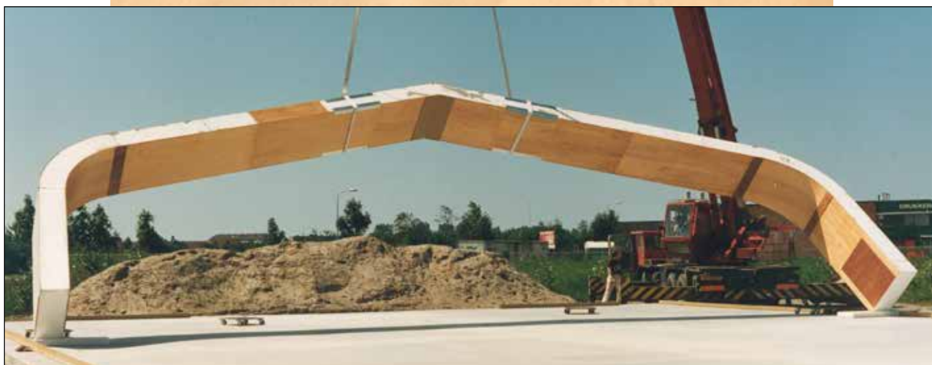
Newood, construção industrial, segmento de casco em 1,25 m de largo e uma espessura de 400 mm.
